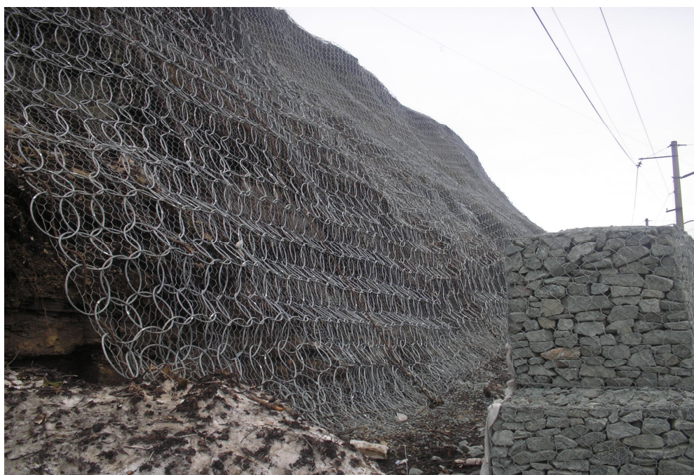
Рис.5.1. Пример применения сетчатого покрытия ООО «Гео-Барьер» для защиты откосов и склонов от камнепада.
